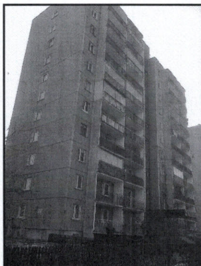
Ilustracja nr 1. Widok na blok przy ul. Ksawerów 23
