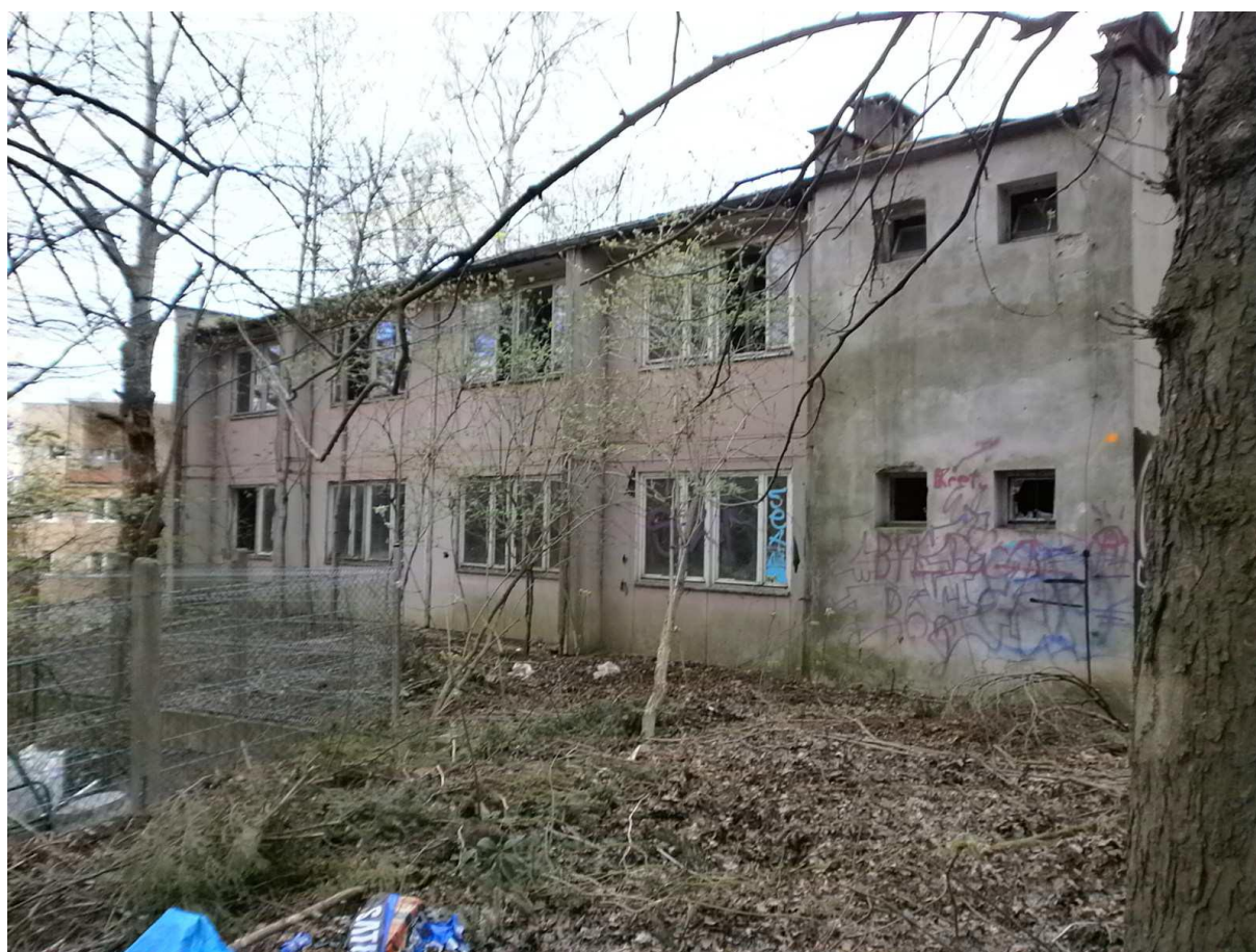
Zdjęcie nr 7 , 8 – Widok na budynek biurowy typu „Diamont”
